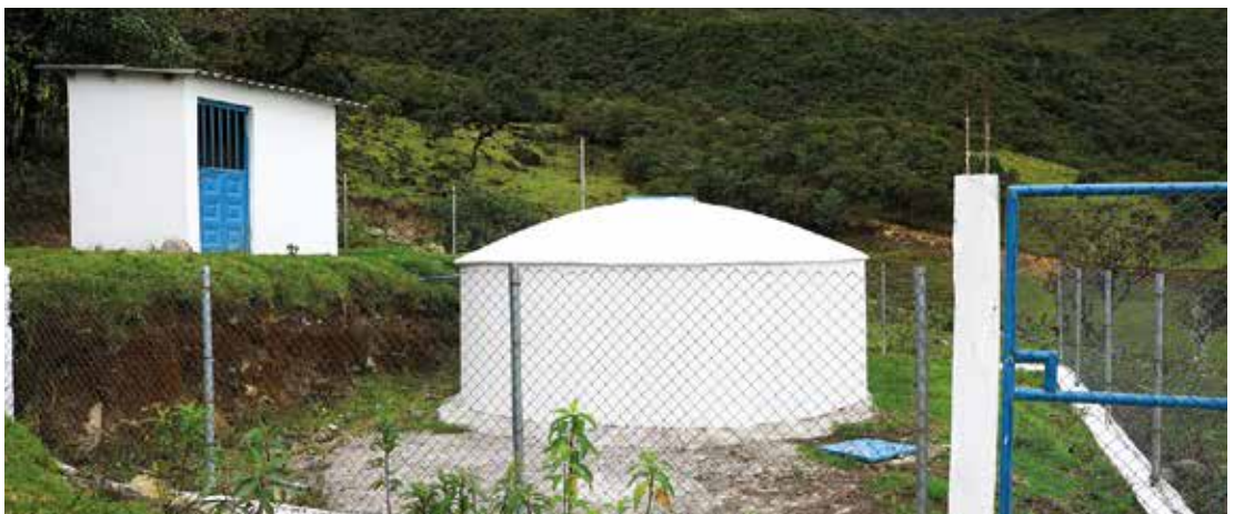
Construcción del sistema de agua potable en la comunidad San Miguel de Las Palmeras
