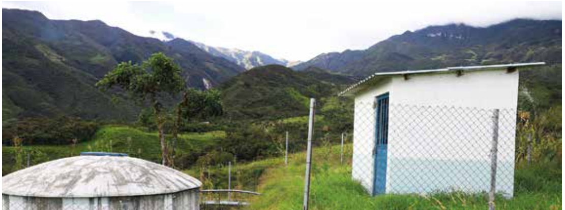
Estamos construyendo el sistema de agua potable en la comunidad Vivar Alto
