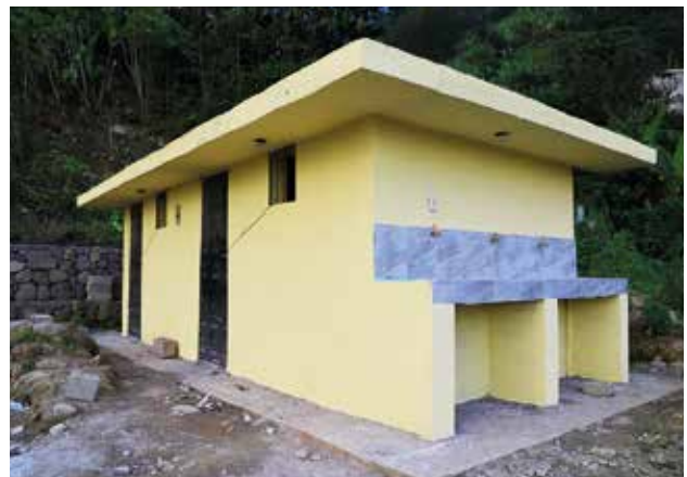
Construcción de cerramiento y batería sanitaria en la comunidad La Cascada
